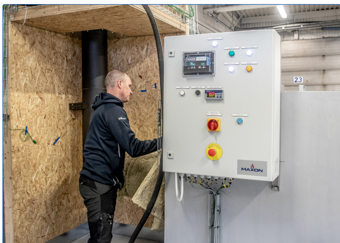
Brännugn redo för provledning av skorsten.
