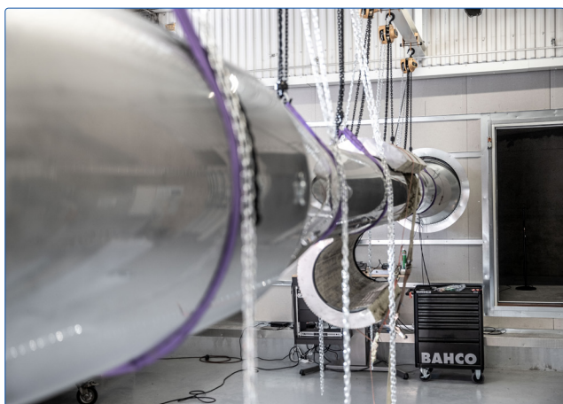
“Mätraketen” med anslutning till efterklangsrummet.
