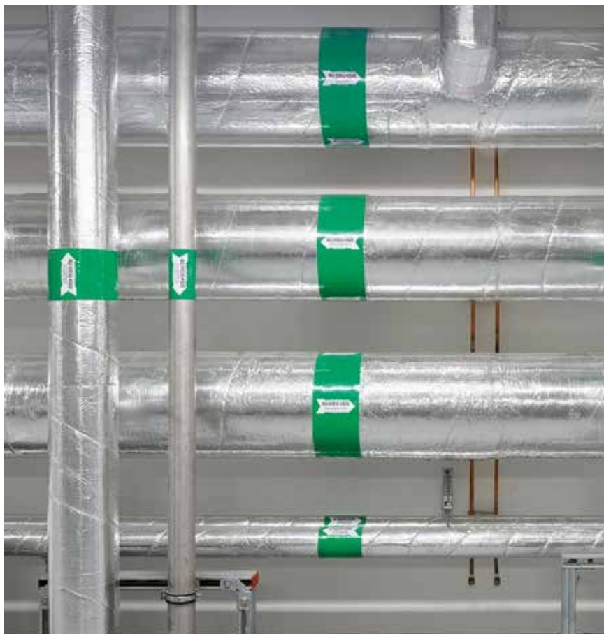
Undercentral isolerad med PAROC Hvac Section AluCoat T.
